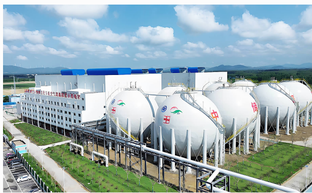
肥城 300MW 盐穴压缩空气储能电站
